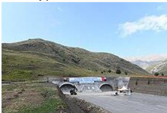
Şək. 3.4.4. Murovdağ tuneli 16 avqust 2021-ci il
