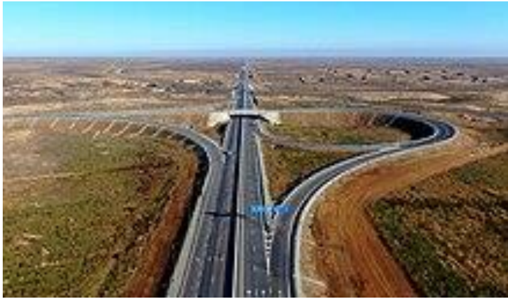
Şək. 3.3.1. Bərdə-Ağdam yolunun qovşağı. 2023
